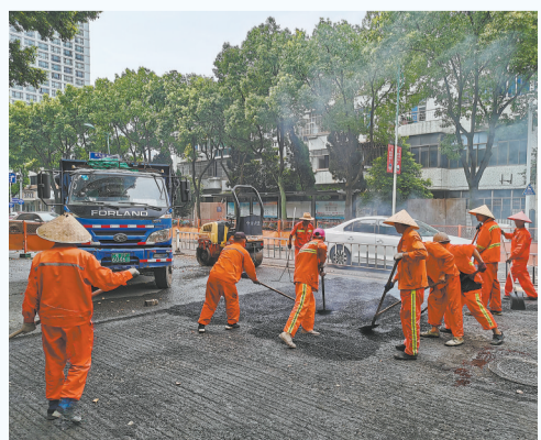
养护工人开展市政道路养护工作
