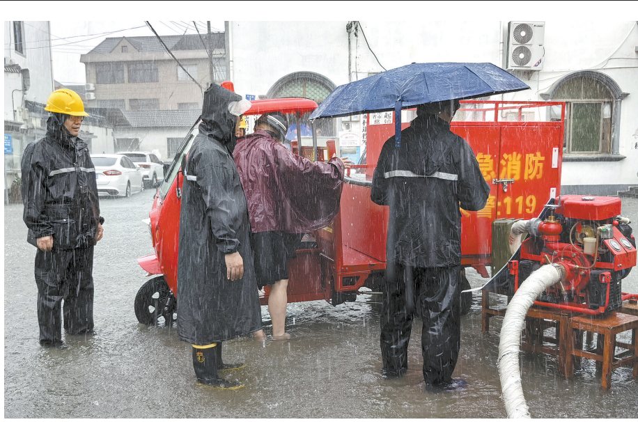
昨天，掌起镇厉家村组织防台应急处置队伍，对环城西路积水严重路段展开紧急抽排作业，全力以赴保障道路尽快恢复畅通。 ■摄影 全媒体记者 王烨江 通讯员 茅译文
