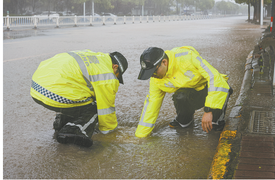
市交警部门对城区严重积水地段进行交通疏导，并及时疏通下水井，保障交通畅通。 ■摄影 全媒体记者 蒋亚军 通讯员 胡志东
